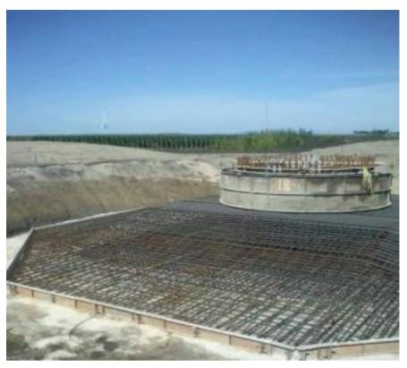
Socle béton éoliennes de 150 à 200 mètres de hauteur
