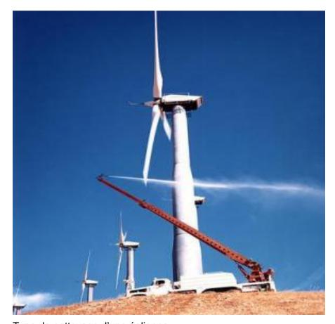
Type de nettoyage d'une éolienne
